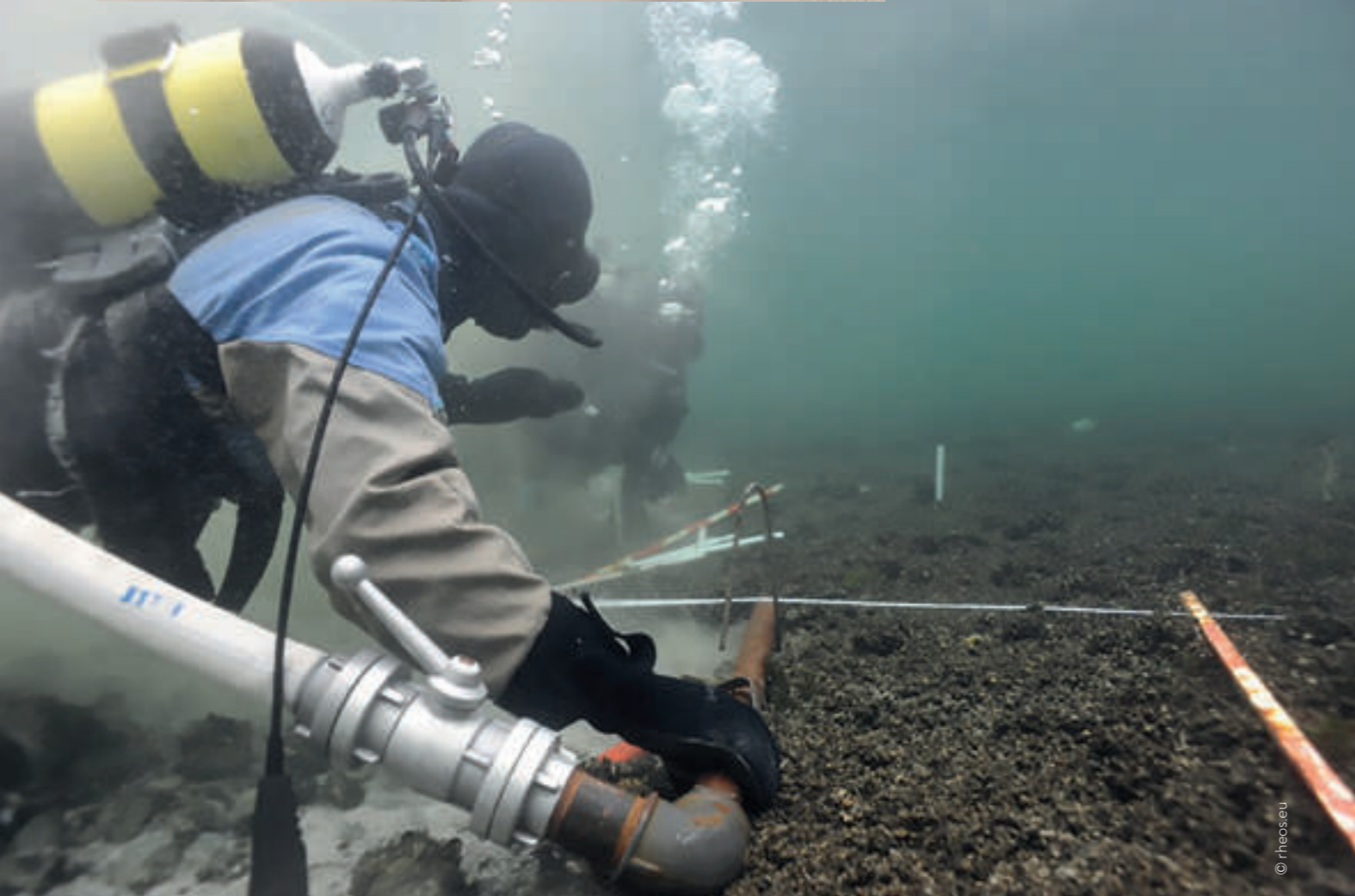
Überlingen-Osthafen 2019. Von Quagga-Muscheln dicht besiedelter Seegrund im Pfahlfeld von Überlingen-Osthafen. Zur Pfahlfeldaufnahme wird der Muschelteppich mit Hilfe künstlicher Strömung (sog. Strahlrohre) entfernt.
