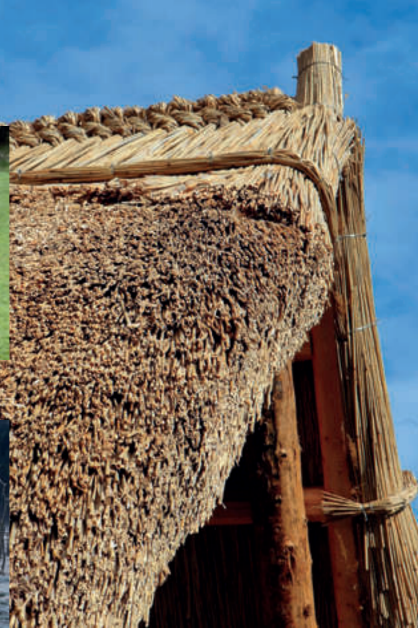
Dettaglio ricostruzione copertura con l'utilizzo di materiale vegetale
