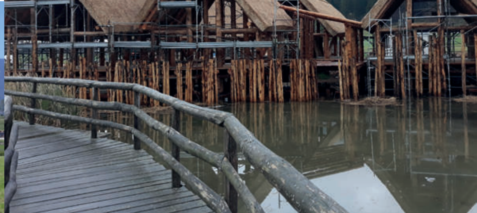
Work in progress della ricostruzione delle capanne del villaggio Fiaavè 6 in base alla distribuzione delle fondazioni a platea reticolata regolare
